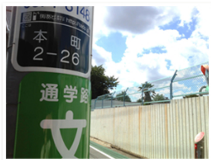
解体工事中の渋谷区立本町小学校
