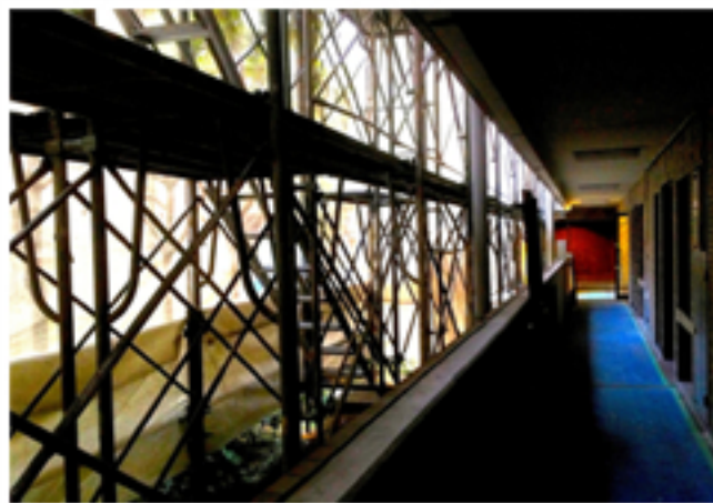
大規模修繕工事中の建物の内部
