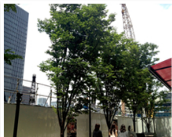
オフィス街に現れた掘削現場
