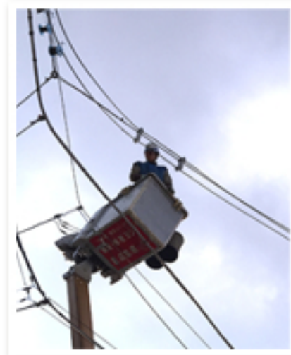
高所作業車で電線に鳥よけのワイヤーを張る
